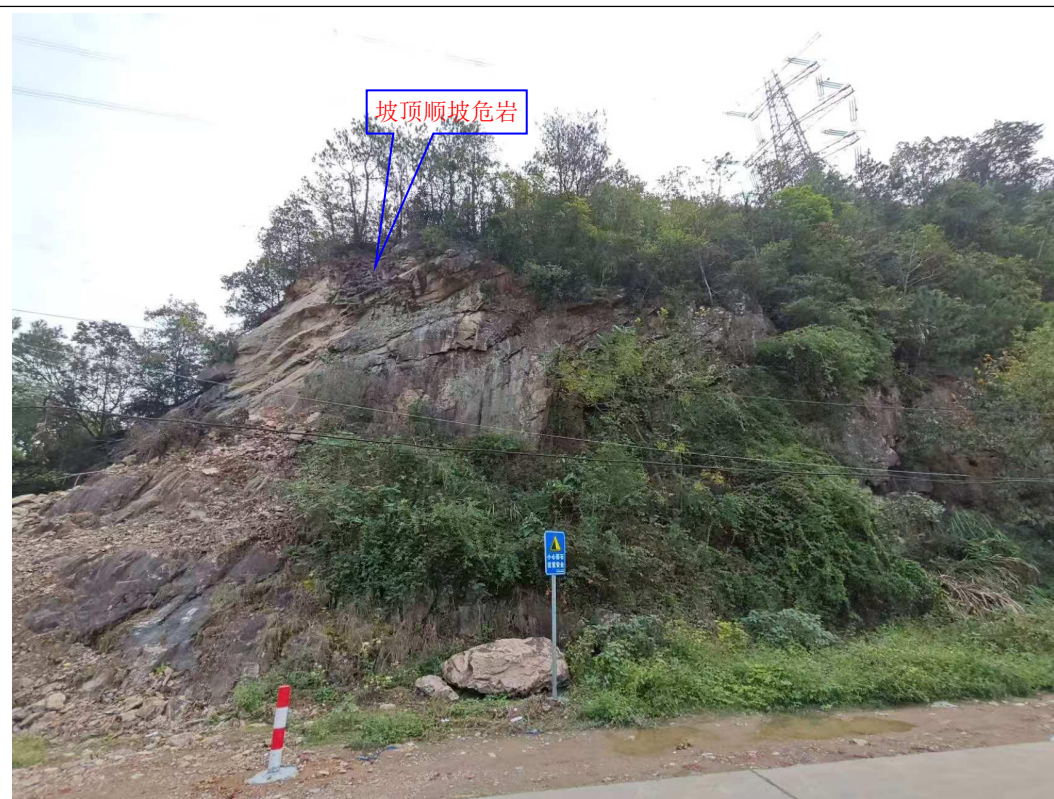
照片 3 坡顶顺坡倒挂岩体（镜像东）
